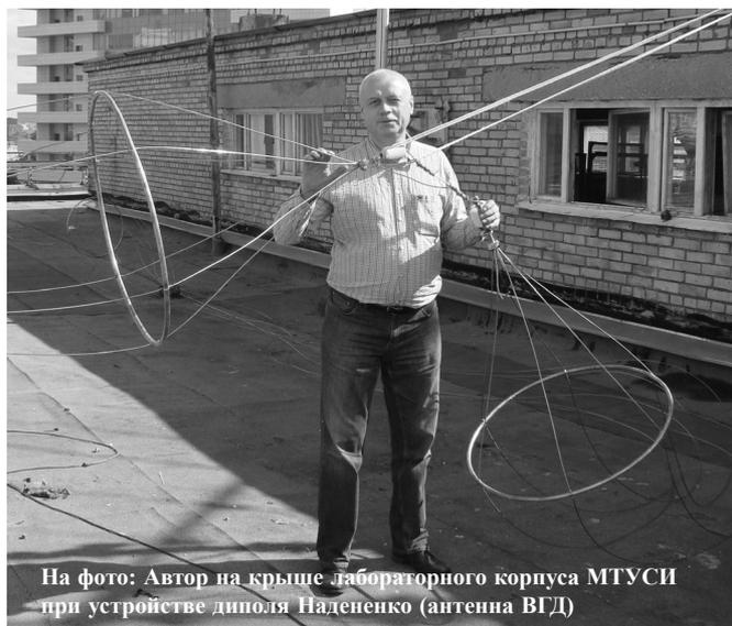
На фото: Автор на крыше лабораторного корпуса МТУСИ при устройстве диполя Надененко (антенна ВГД)
