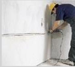
В стенах по нанесенной разметке (от щитка) пилой-"болгаркой" с абразивным кругом прорежьте контуры штробов на глубину 4-5 см. Ту же операцию повторите на оштукатуренном потолке.
