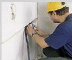
Шланг, независимо от того пропущены ли в него провода или они будут затягиваться позже, уложите в штроб так, чтобы его конец вышел в нишу для установочной либо ответвительной коробки, и временно закрепите на стене предварительно разведенным алебастром, наносимым шпателем.
