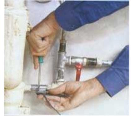
3. Крепление конца медного провода к трубе с помощью специального металлического хомута
