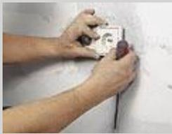
Декоративно-защитную накладку розетки (выключателя) закрепите снаружи винтом.
