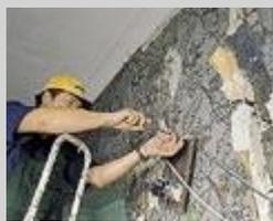
Сначала удалите старый квартирный щиток, открытую и, где нужно, скрытую электропроводку. Питание временно возьмите с кабельного ввода в квартиру (подключение произведите в соответствии с общими электротехническими правилами).
