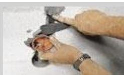
Пластмассовые коробки для установки розеток и выключателей, а также ответвительные коробки, в которые заведены концы проводов, закрепите на стене алебастром.
