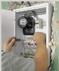
Установочные устройства в щитке (УЗО, защитные автоматы) соедините между собой с помощью шины.
