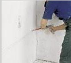
Штроб в пределах пропилов выдолбите с помощью скarpели и молотка на глубину, достаточную для укладки ПВХ-шланга, в который будет затягиваться провод.
