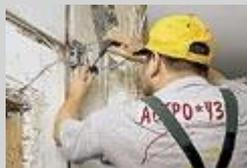
Провода в ответвительных коробках соедините с помощью винтовых клемм.
