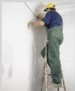
В скрытый шланг затяните провод сначала тросиком-протяжкой со стороны ближайшей розетки или ответвительной коробки, а затем руками. Концы провода закрепите в клеммах соответствующего распределительного устройства
