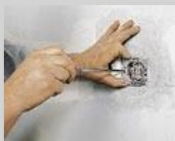
Провода, заведенные в подрозеточную коробку, соедините с тремя клеммами штепсельной розетки "под винт", после чего в коробку установите розетку, которую зафиксируйте на стене в горизонтальной плоскости с помощью регулировочных винтов. Аналогичным образом установите выключатель.
