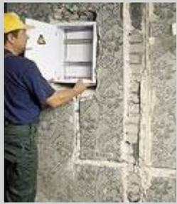
В нишу, предварительно выдолбленную в стене, установите новый квартирный щиток, который (на первом этапе электромонтажа) зафиксируйте с помощью деревянных клиньев. Впоследствии привинтите его к стене шурупами с дюбелями, щели замажьте алебастром.
