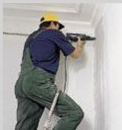
В межкомнатных перегородках перфоратором пробейте отверстия, через которые из одного помещения в другое протяните защитные ПВХ-шланги.
