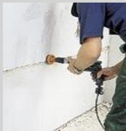
В местах установки розеток, коробок, выключателей дрелью со специальной режущей насадкой высверлите под них отверстия.
