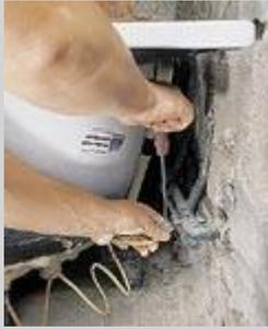
Трубу холодного водоснабжения соедините с "землей" квартирного щитка через тот же клеммный распределитель. Для этого провод-заземлитель сечением 6 мм<sup>2</sup> проложите под плинтусом и введите в коробку щитка через ПВХ-шланг. Один конец провода-заземлителя закрепите к трубе стальным хомутом, а другой зафиксируйте на щитке отдельным болтом.
