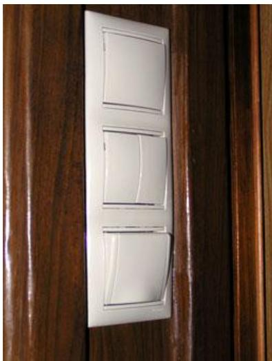
Ещё Вам понадобится подключить общий провод из распределительной коробки на на средний контакт датчика, на схеме - "общ.". Обычно рядом с ванной комнатой располагается блок выключателей с розеткой. Провод, который идёт к одному из контактов такой розетки и больше никуда и есть общий.
