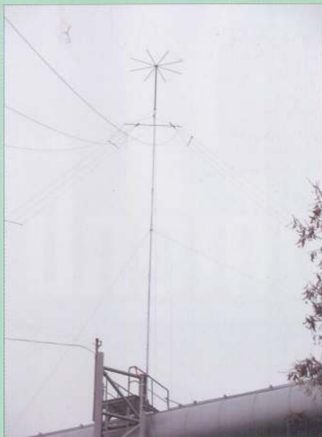
Двухчастотная передающая антенная система на средние и короткие волны.
