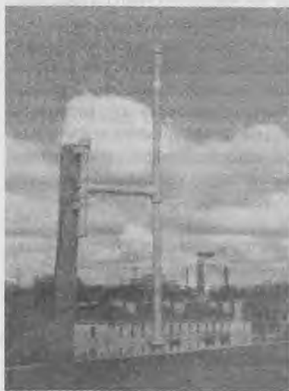
Фото 1. СВ антенна для связи в диапазоне 168 МГц
