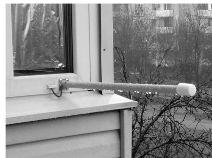
Рис. 10. Монтаж выносного датчика. Испытание морозом и дождем
